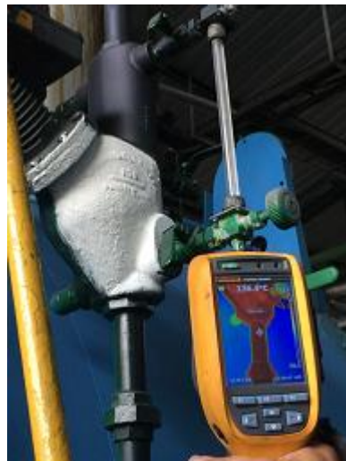
Foto-11: temperatura sobre zona sin T-260 lado vapor =171.5°C; Foto-12: temperatura sobre zona sin T-260 lado agua =136.4°C; ; Foto-13: temperatura sobre zona con T-260 lado agua lado línea de nivel =122.7°C.
